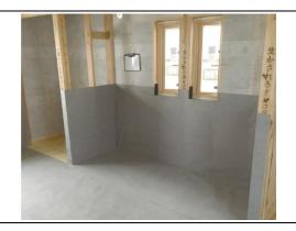
床立ち上がり部分から柱にタッカーで留めながら横方 向にシートを敷き詰める。
